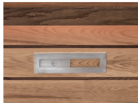
Camino per aerazione Ventilation grid
